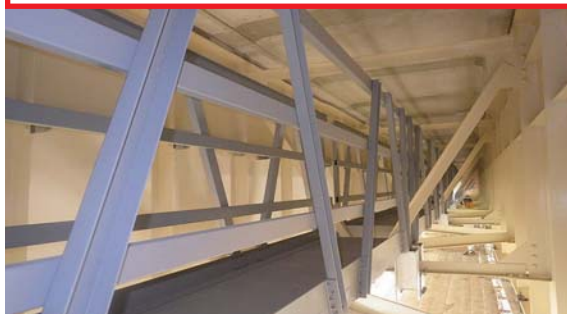
〈上部工検査路-1〉
