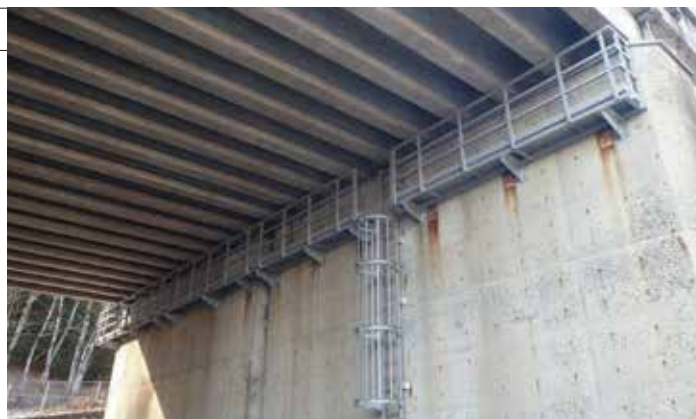
●下部工検査路
