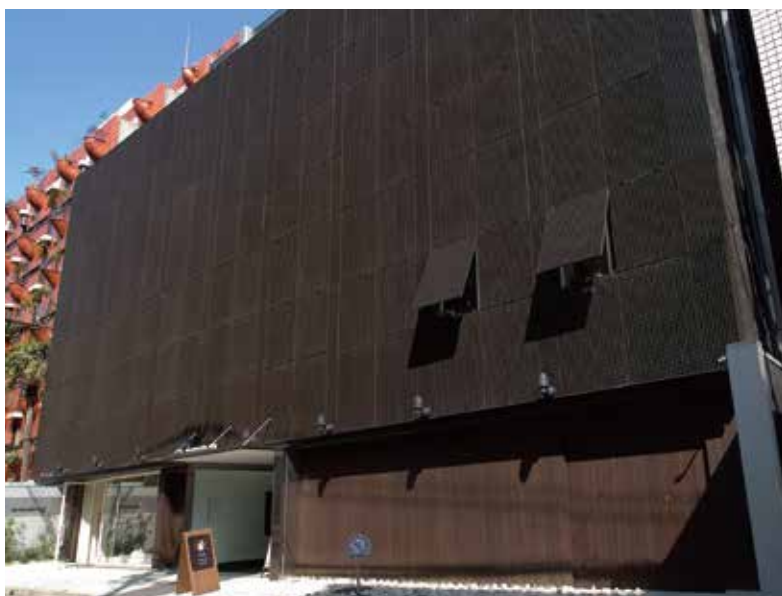
■ 南船場商業ビル
