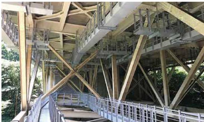
●上部工検査路-1
