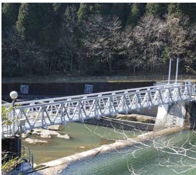
■ 鹿児島県「管理橋」
