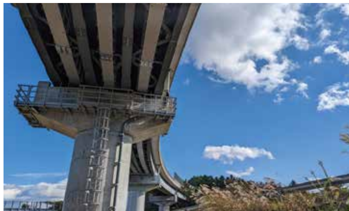
●上部工検査路-2
