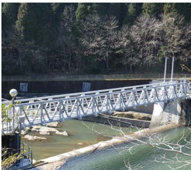
■鹿児島県「管理橋」
