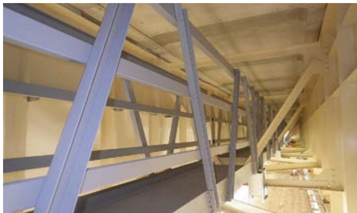
●上部工検査路-1
