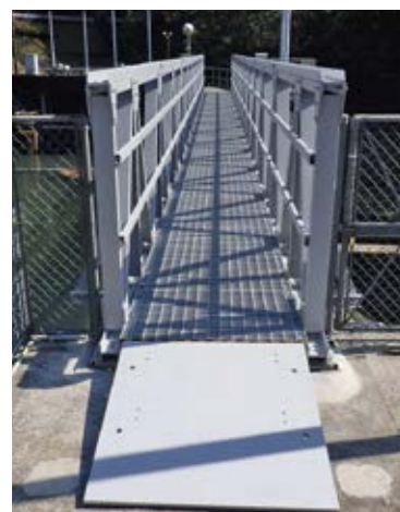
●管理橋 歩廊部
