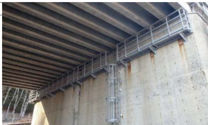
●下部工検査路
