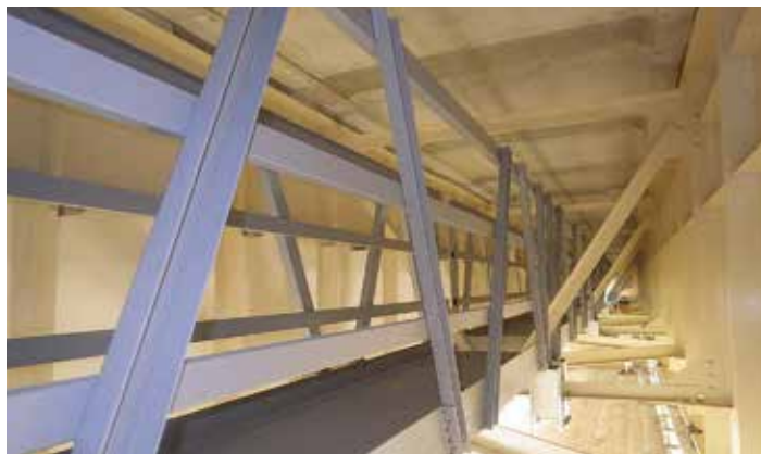
●上部工検査路-1
