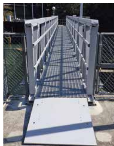
●管理橋 歩廊部
