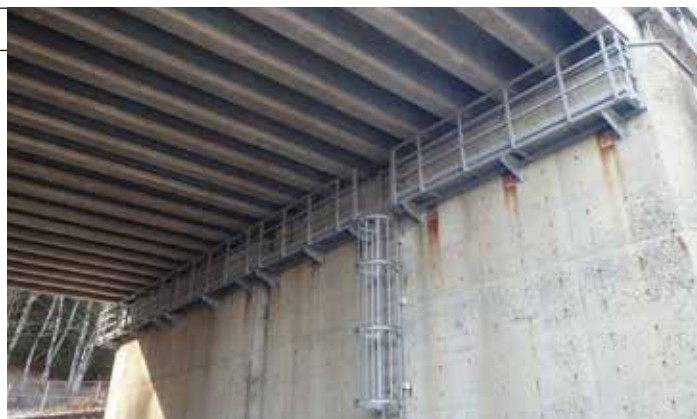
●下部工検査路
