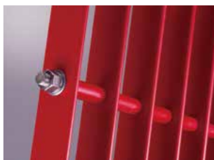
取水塔スクリーン(北海道 幌向ダム)
