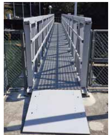
●管理橋 歩廊部
