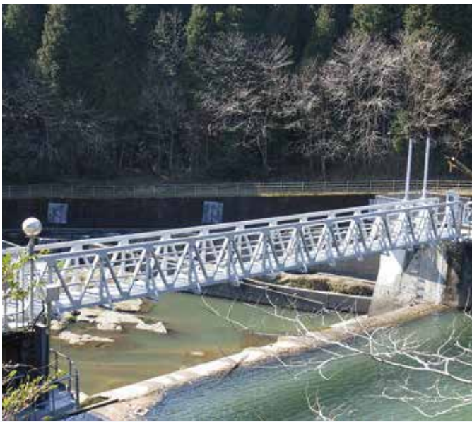
■鹿児島県「管理橋」
