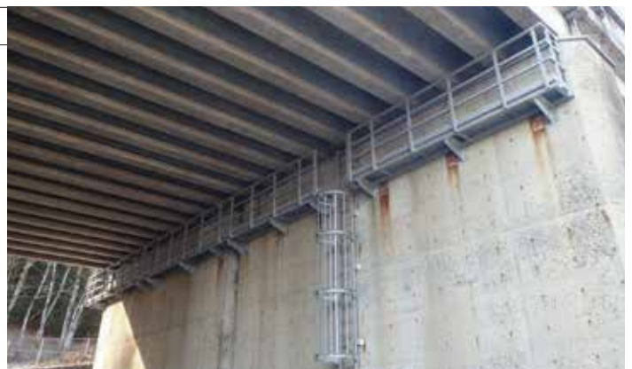
● 下部工検査路
