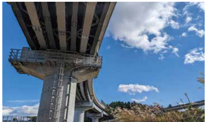
● 上部工検査路-2
