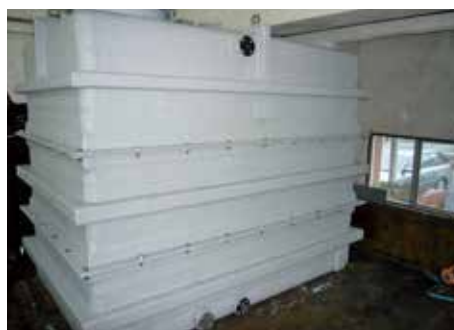
● FRP製薬品タンク
