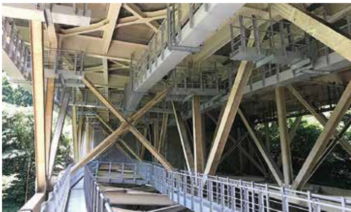
● 上部工検査路-1
