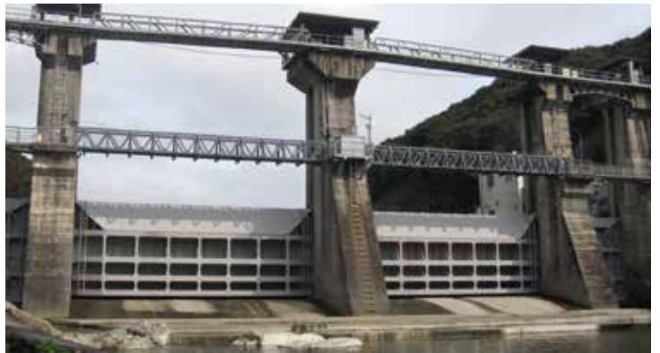
●人道橋(管理橋(九州電力 川上第五発電所 17.8mトラス橋))
